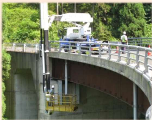
橋梁点検車による点検
