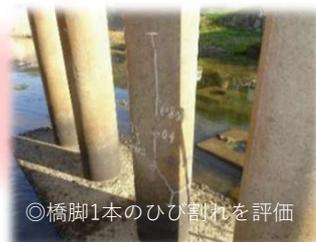
損傷個所の評価をもとに部材の対策区分を決定する。
