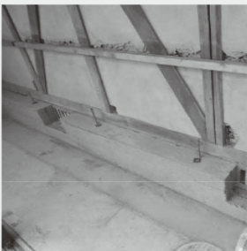
基礎補強(増打ち)
