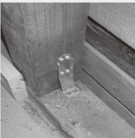
接合部金物補強
