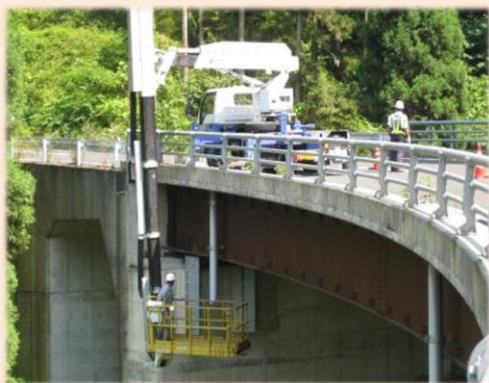
橋梁点検車による点検
