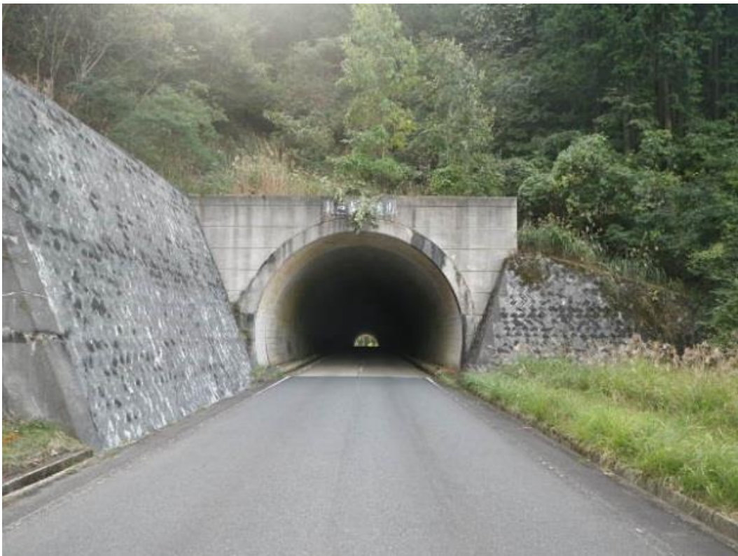
影石谷トンネル
