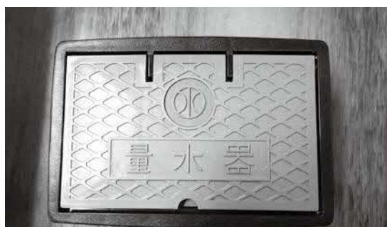
各家庭にある量水器のフタです。プラ製と金属製のフタがあります。
