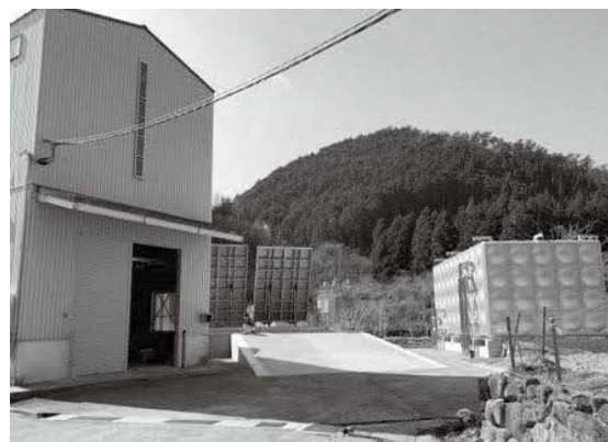
▲別府地区 エネルギーセンター
