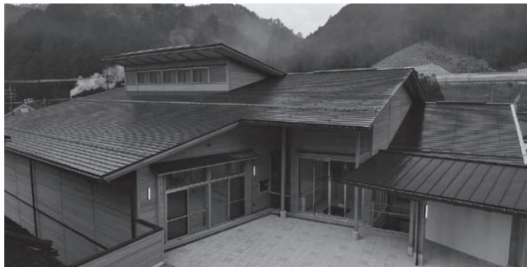
東側からの外観です。写真右側（北側）に引き続き第2工区の建物が建設されます。
