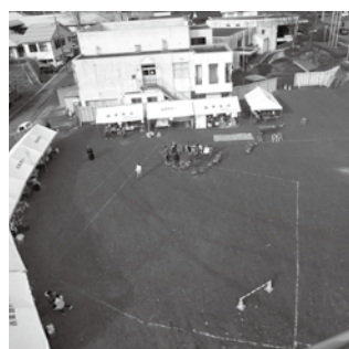
高所作業車からみた第一工区の敷地。
