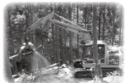
山土場等で集材されてきた材の枝払い、測尺、玉切りなどの作業を行います。
