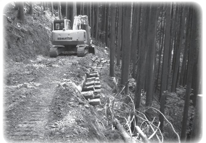
②バックホウを使って作業道の開設
