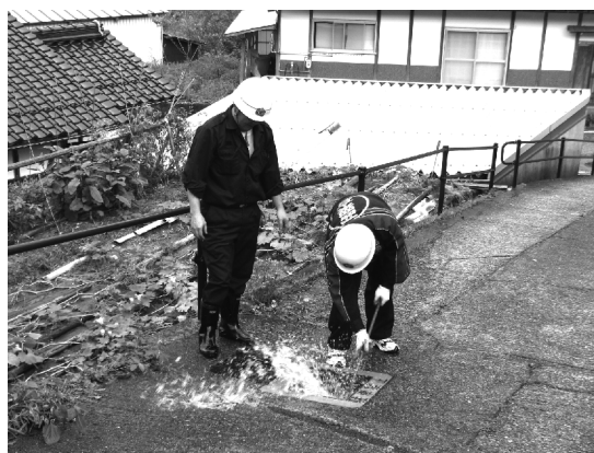
塩谷地区の消火栓点検の模様
