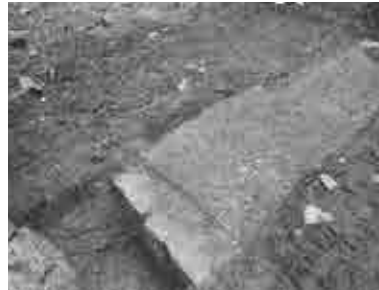
明治に整備された国道 と思われる側溝が出現
