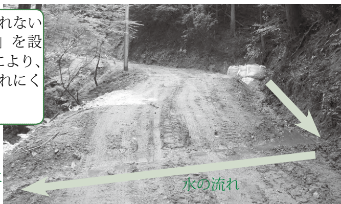
【作業道を水が流れないように行う工夫】
