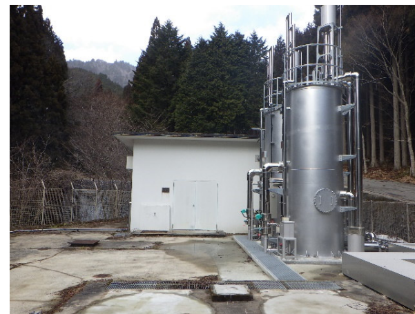
老朽化に伴い施設更新を行った浄水場
