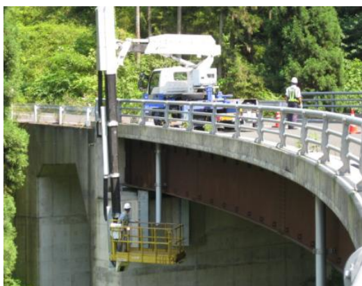
橋梁点検車による点検状況
