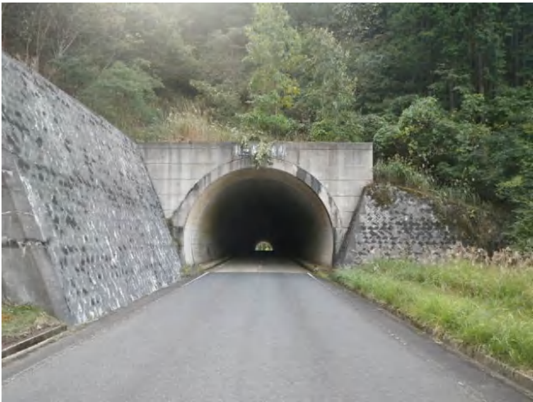
影石谷トンネル
