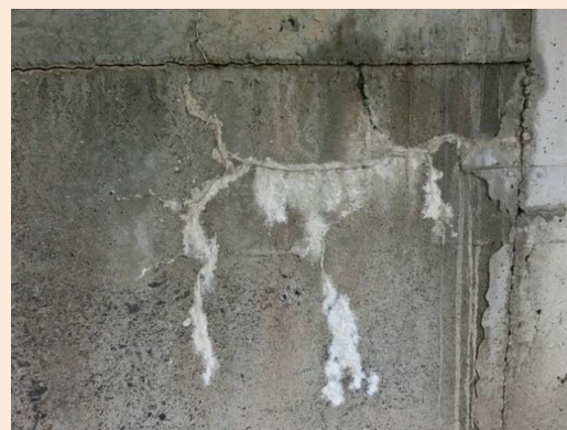
下部工のひび割れ
