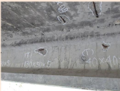
主桁及び床版部の鉄筋露出
