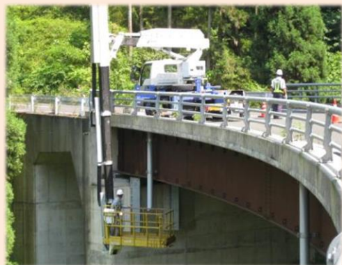
橋梁点検車による点検
