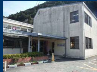
建替予定の子育て支援施設
