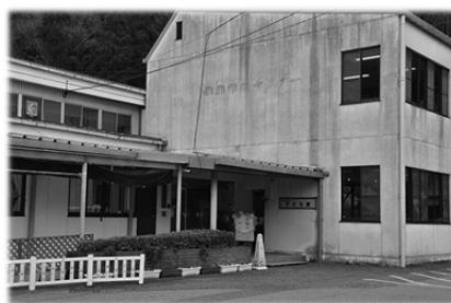
老朽化が進むあわくら会館（左）と需要の高まりに対する対応が必要な子ども館（右）
