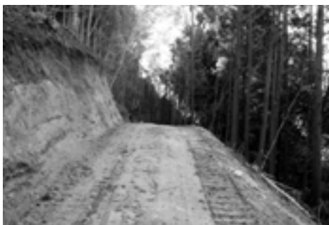
影石地内の私有林で 開設した作業道
